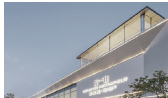
顶部 轮廓照明、泛光照明
